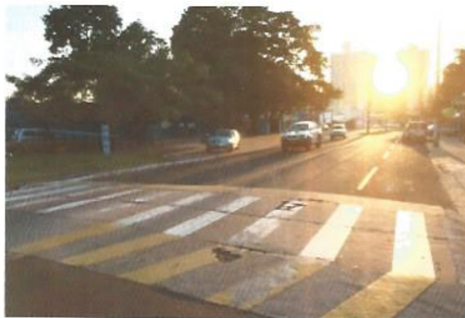
Instalação de um quebra-mola para pedestres em lombada de elevação (Foto: César Cordeiro)
