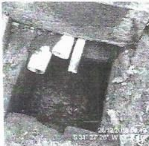
Figura 3- Ligações na rede pluvial
